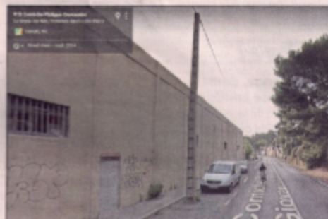
D'aucuns ont sans doute oublié que, durant des décennies (et jusqu'en 2016), un bâtiment industriel masquait tout ou partie de la vue sur mer. (Photo Google)
